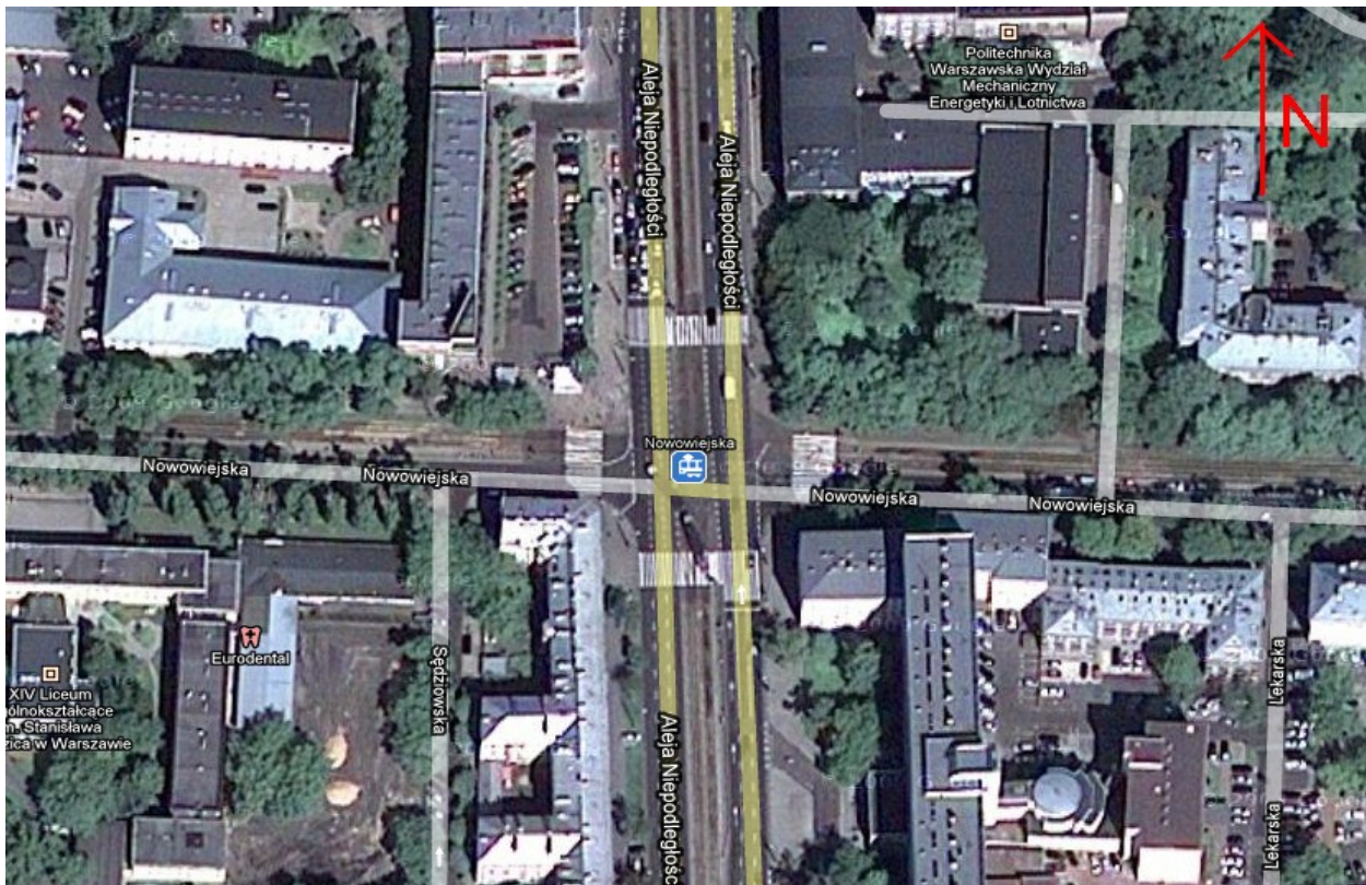
Fig. 1. Air view of the crossing of Al. Niepodległości and Nowowiejska
